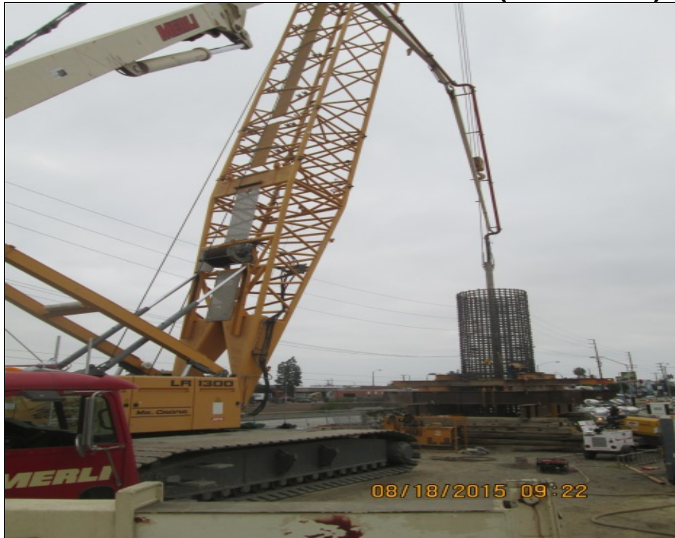
I-405 Underpass Bent 3 CIDH Concrete Pour.
