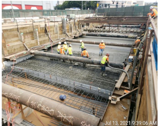
Alameda C/C – Roof slab 7 concrete pour
