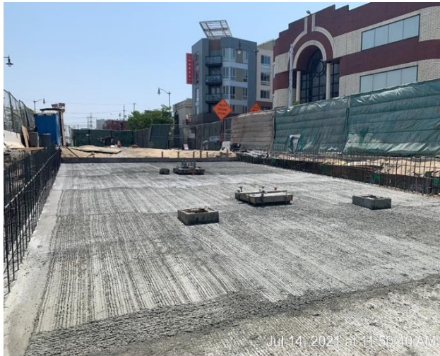
1st street U-Channel – Segment 15 Invert pour
