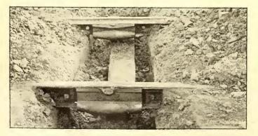
FIG. 86 .- CAST WELDED JOINT.
