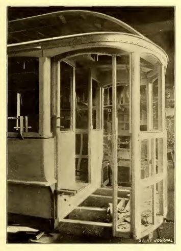
FIG. 6 .- VESTIBULE UNDER CONSTRUCTION.
