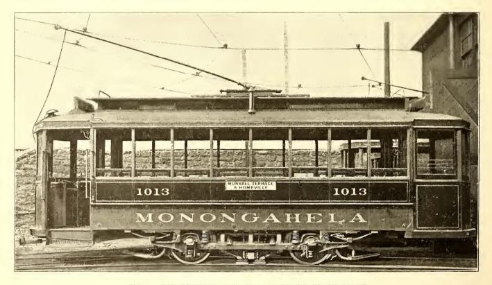
FIG. 1.-CAR EQUIPPED WITH NEW MAGNETIC TRACK BRAKE
