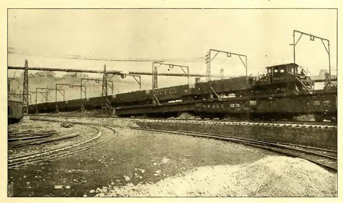
FIG. 4.— EIGHT-WHEELED, FOUR-MOTOR, ELECTRIC LOCOMOTIVE OF CARNEGIE STEEL COMPANY
