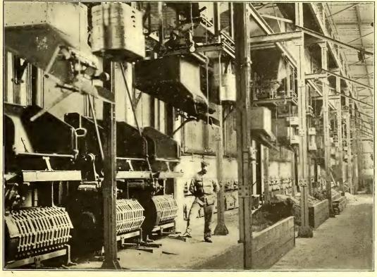
FIG. 10.-BOILER ROOM, SHOWING CHAIN-GRATE STOKERS
