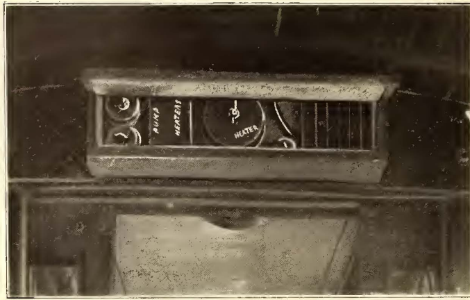
FIG. 17.—SWITCH BOX OVER DOOR
