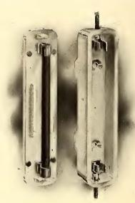
DETAILS OF LONDON TRACK WORK, REINFORCED JOINT USED IN NEW WORK BY THE LONDON UNITED TRAMWAY COMPANY
