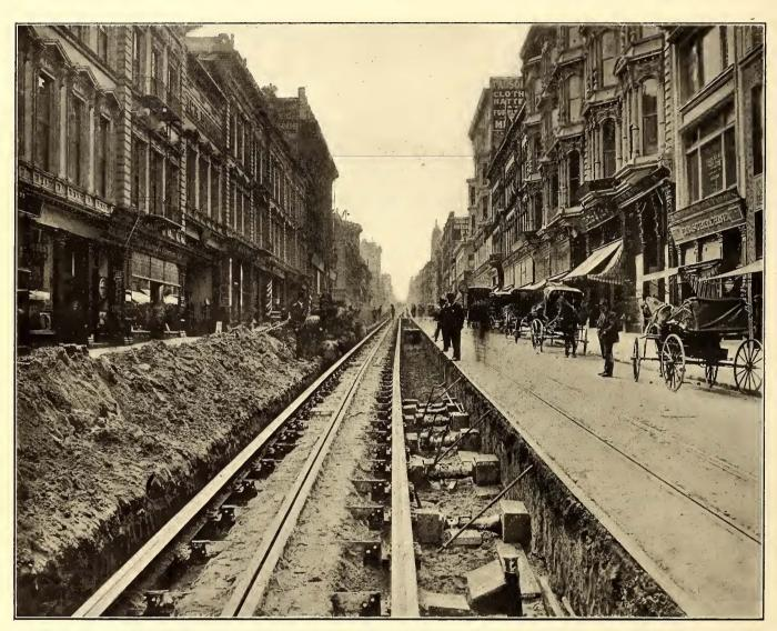
TRACK WORK ON THE SUTTER STREET LINE, SAN FRANCISCO, BEFORE THE FIRE. THE JACKS ARE IN POSITION FOR MOVING OVER THE BED OF THE TRACK
