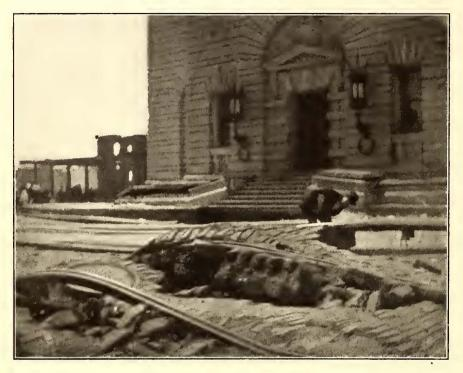
WHAT THE EARTHQUAKE DID TO THE TRACK AND ROADBED OF THE CABLE SYSTEM IN FRONT OF THE SAN FRANCISCO POST OFFICE
