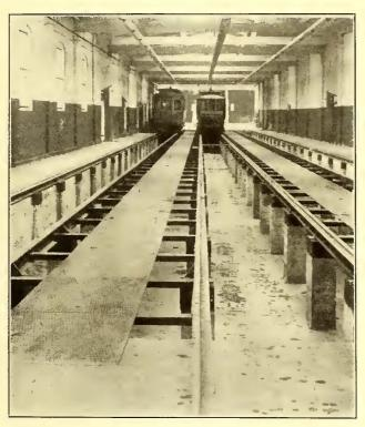
FIG. 23.--PIT CONSTRUCTION OF NEW CAMDEN CAR HOUSE
