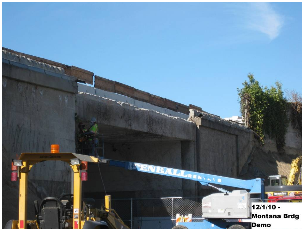
Montana Bridge demo.
