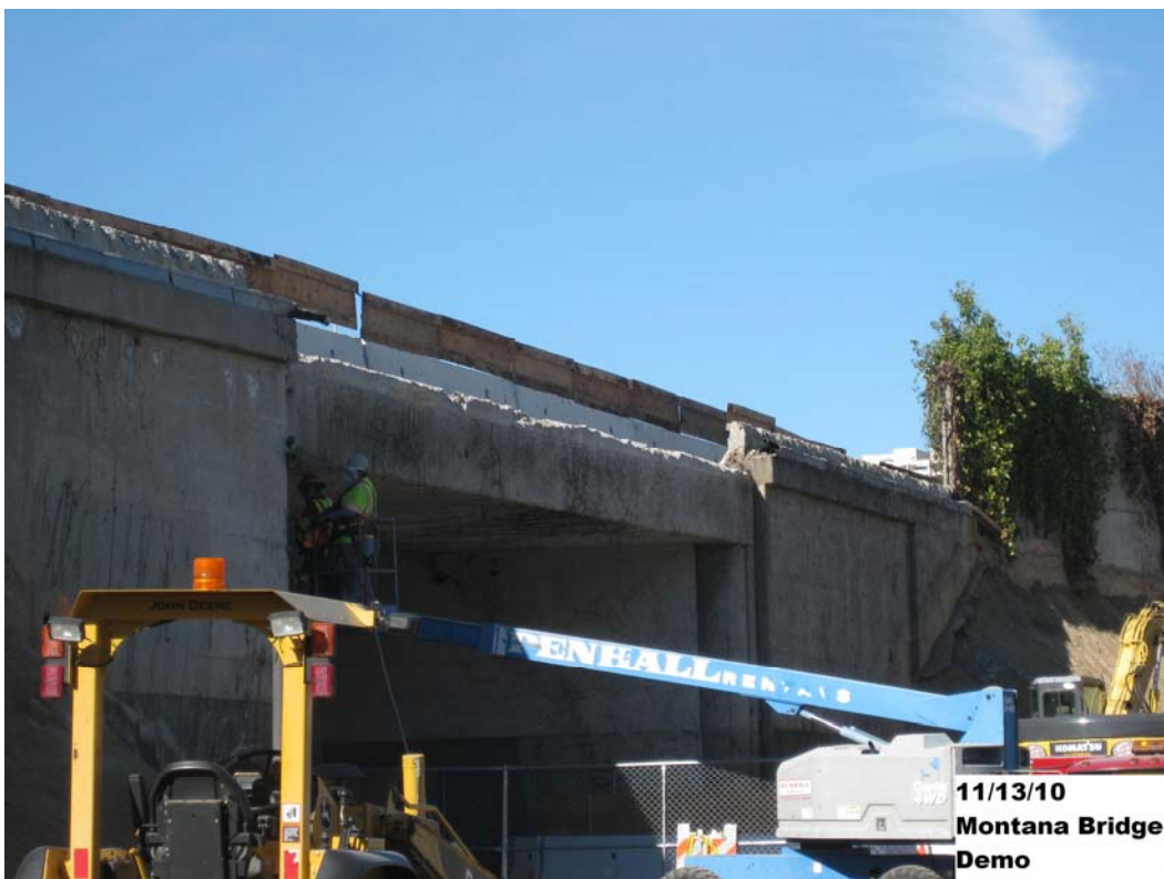
Montana Bridge demo.
