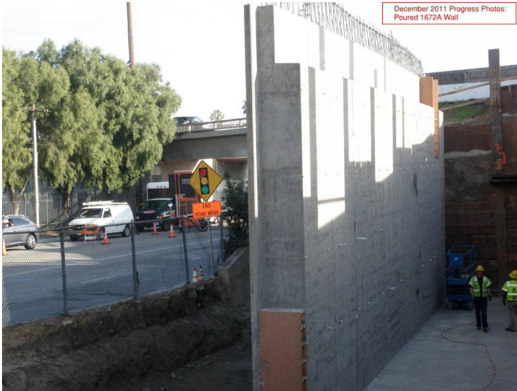
Poured 1772A Wall.
