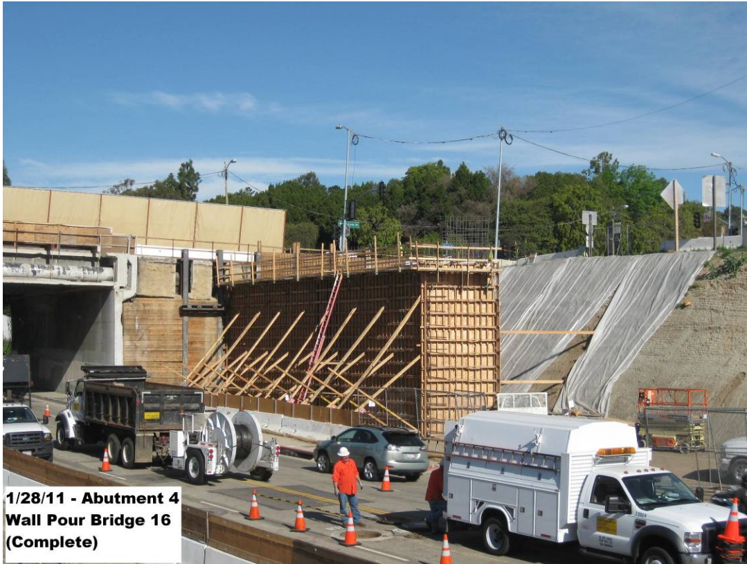
Abutment 4 Wall Pour Bridge 16 (complete).
