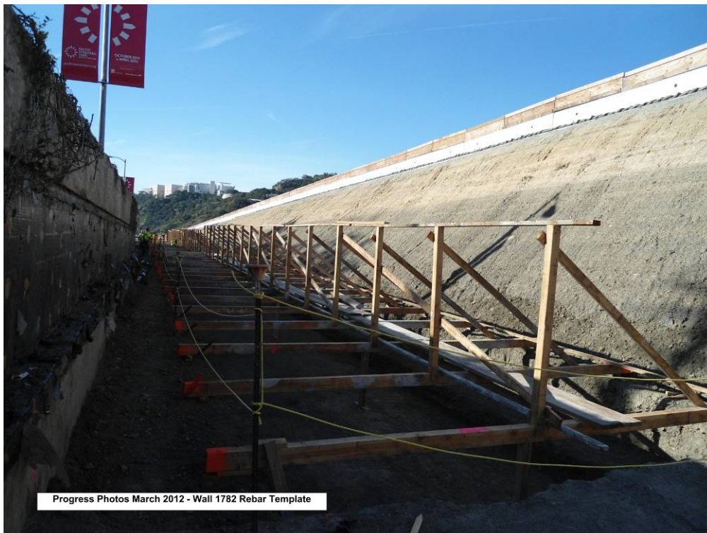
Wall 1782 rebar template.
