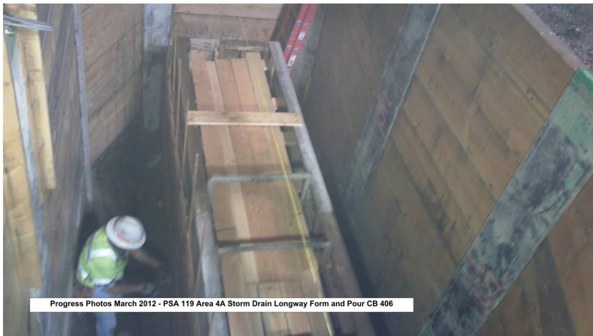
PSA 119 Area 4A storm drain longway form and pour CB 406.
