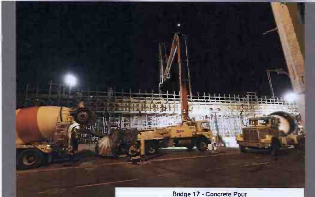
Bridge 17 - Concrete Pour
