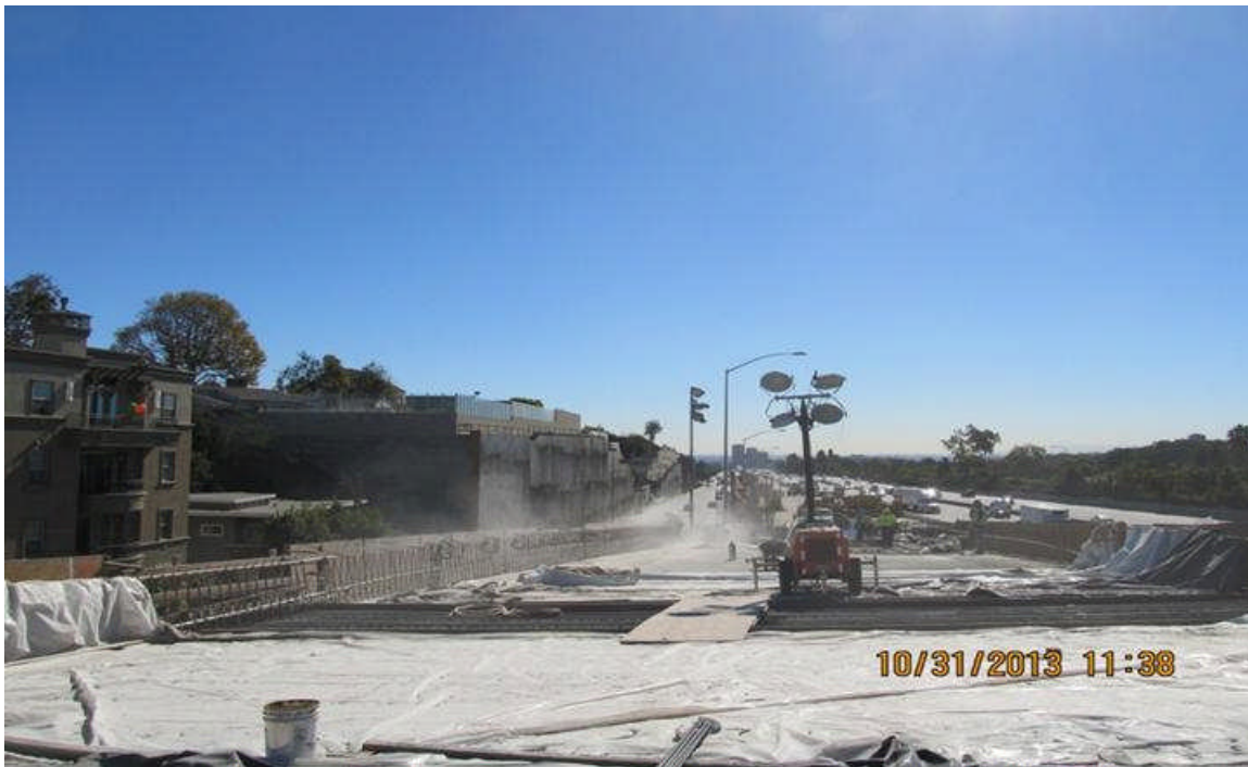
Bridge 14 Top Deck Pour.
