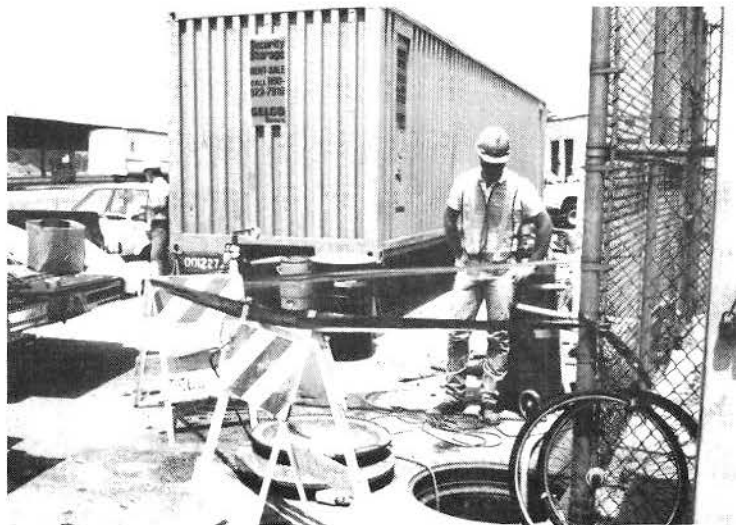
ASBESTOS ABATEMENT IN MANHOLE 10E
