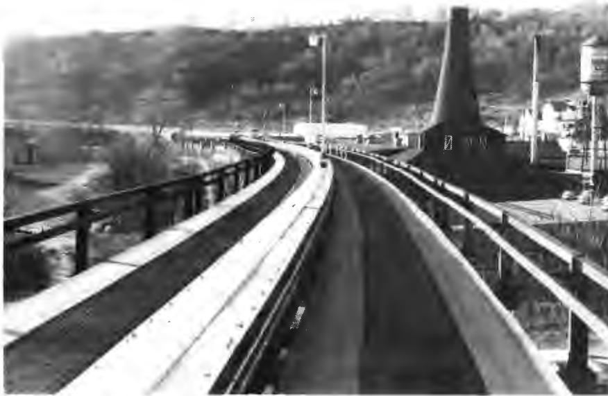
FIGURE 4.50 : GUARD RAILS AT SIDES OF GUIDEWAY
