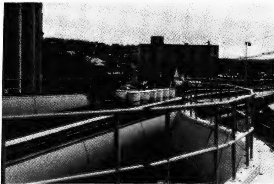
FIGURE 3.42 : SAND FILLED PLASTIC DRUMS AT TURNOUTS
