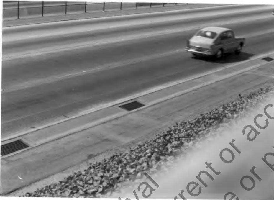
FIGURE 4-2. GRATINGS IN GUTTER FLOW-LINE
