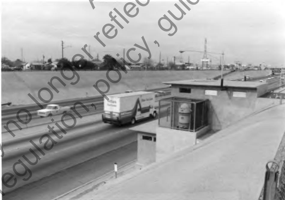
FIGURE 3-4. POORLY SITED STATION IN ARIZONA
