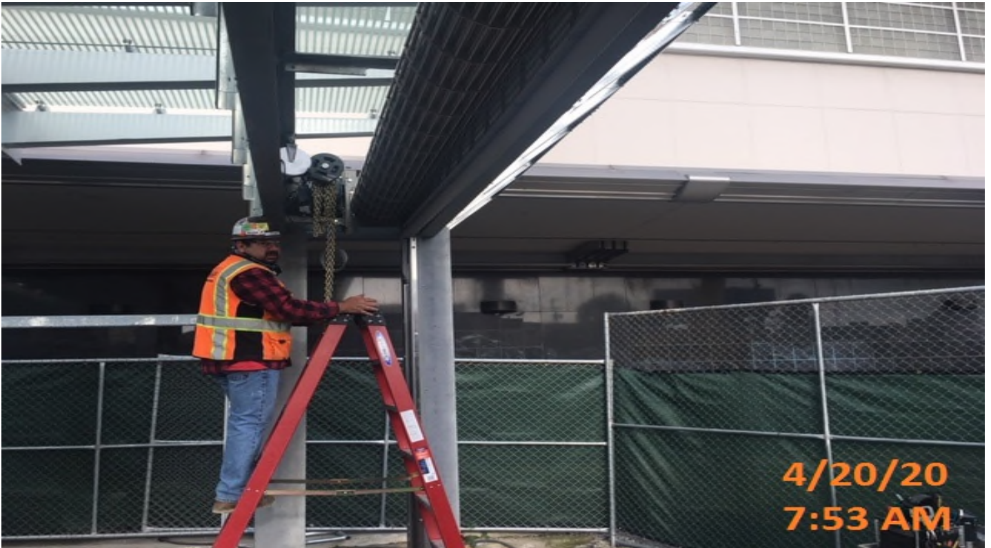
Crenshaw/MLK - MLK – McKendry Door installing motor for rolling door grille
