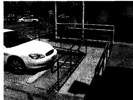
ADA Access Ramp
