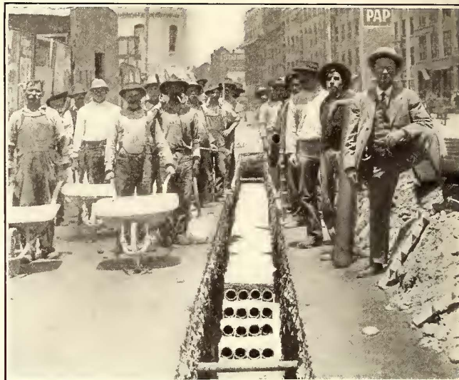
Fiber Conduit Installation in Los Angeles.
