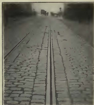
SIDE CONDUIT IN BRUSSELS
