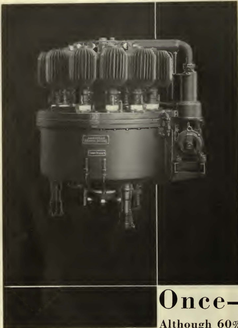
Mercury Arc Power Rectifier for 600 volt D.C. service
