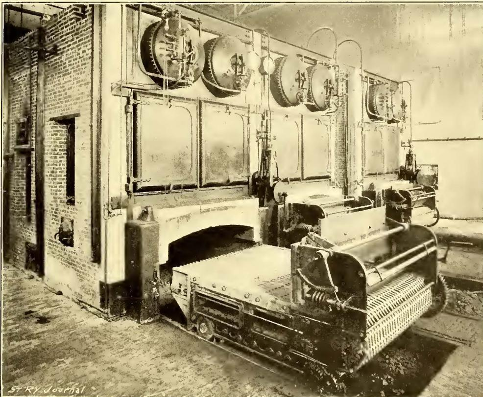
FIG. 6.—VIEW OF BOILERS, SHOWING ENDLESS CHAIN GRATE.
