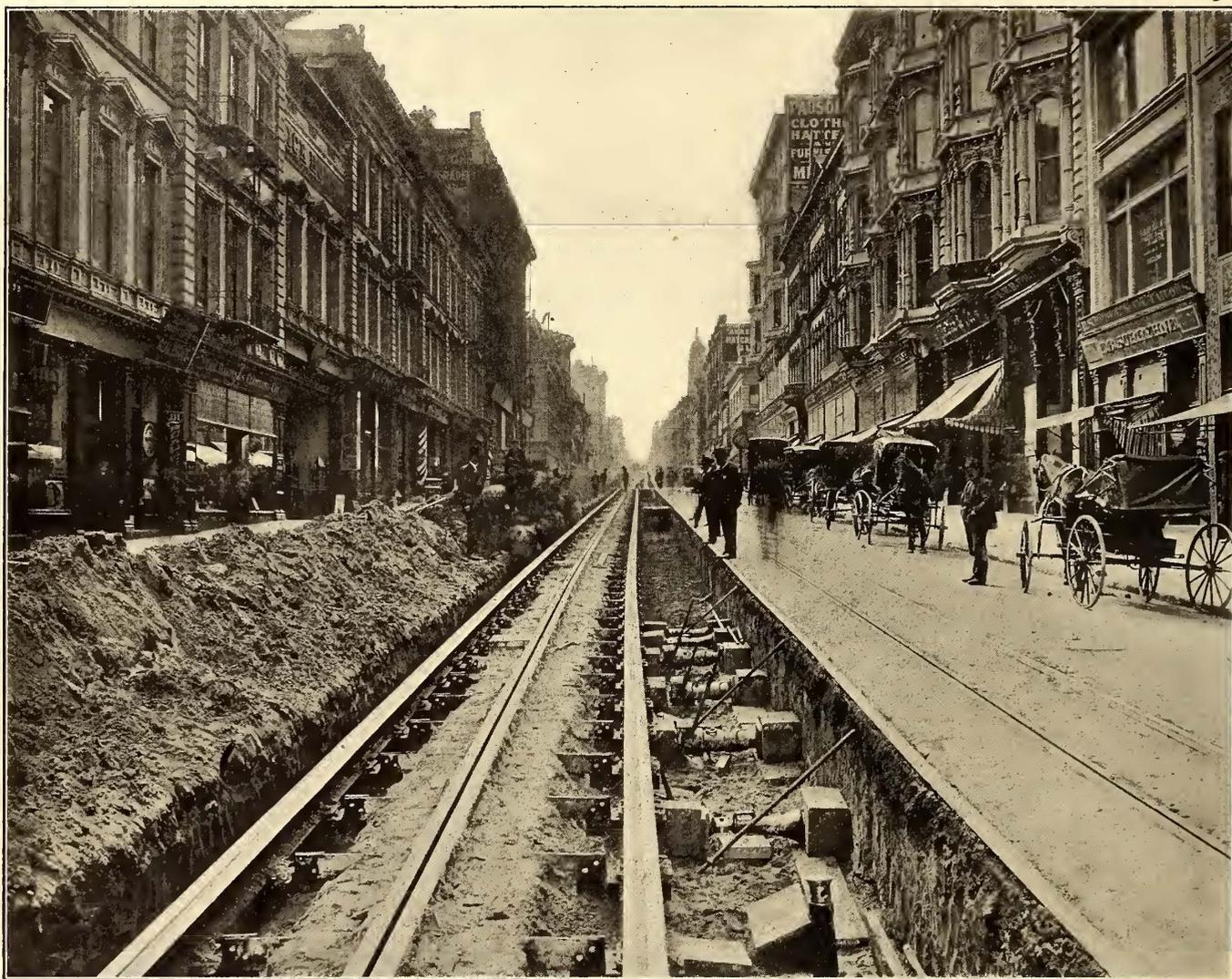
TRACK WORK ON THE SUTTER STREET LINE, SAN FRANCISCO, BEFORE THE FIRE. THE JACKS ARE IN POSITION FOR MOVING OVER THE BED OF THE TRACK
