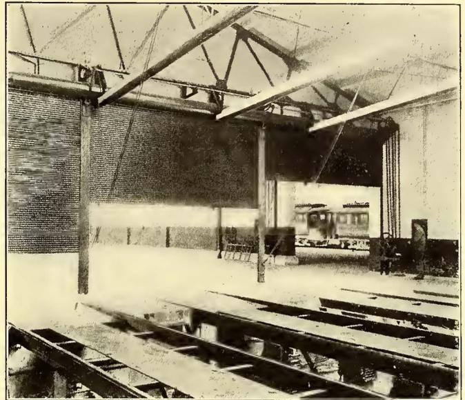
THREE STEEL ROLLING DOORS BEING OPERATED AT DIFFERENT HEIGHTS FROM ONE MOTOR AT THE RIGHT
