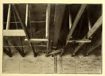
ROOF CONSTRUCTION OF SHOP, TROLLEY TRAVELING ON I-BEAM AND TROLLEY BRIDGE
