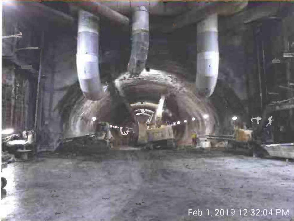
SEM Cavern overview
