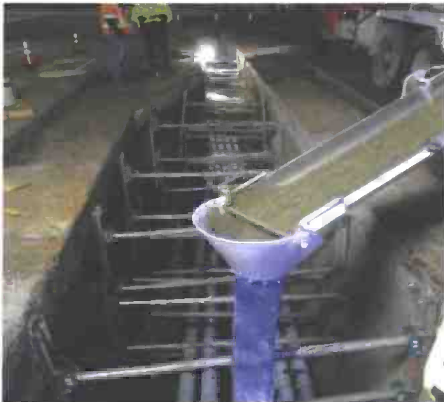
Conduit Encasing on Wilshire Blvd.
