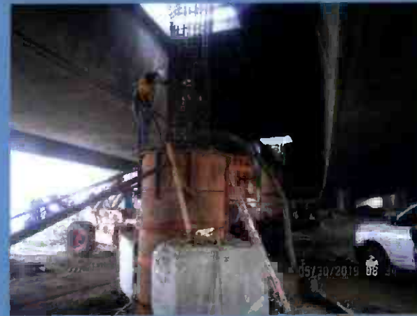
Bent 5 Concrete Base Column Pour
