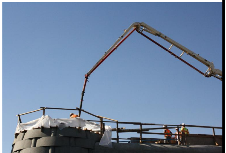
Concrete pour at south basket
