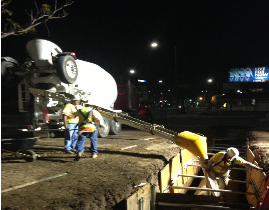
Leimert Park encasement.
