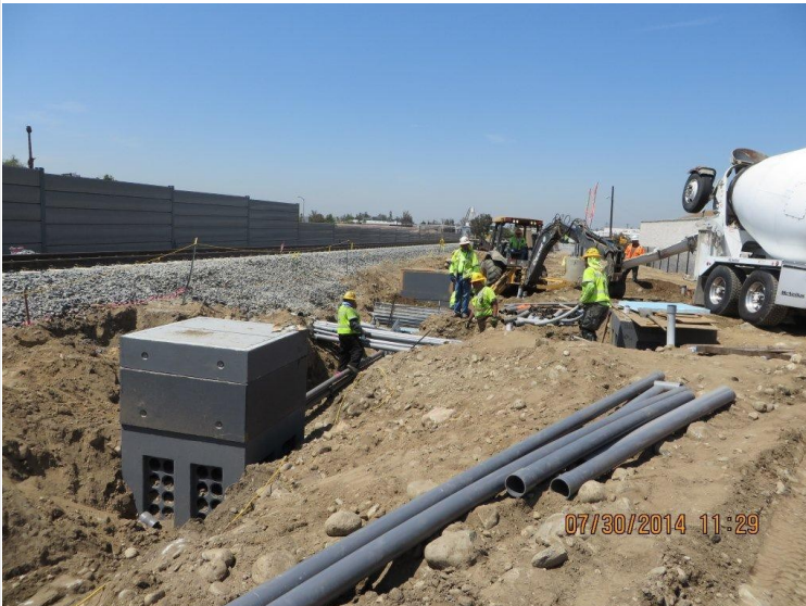
Segment 4: Virginia TPSS - Conduit Installation
