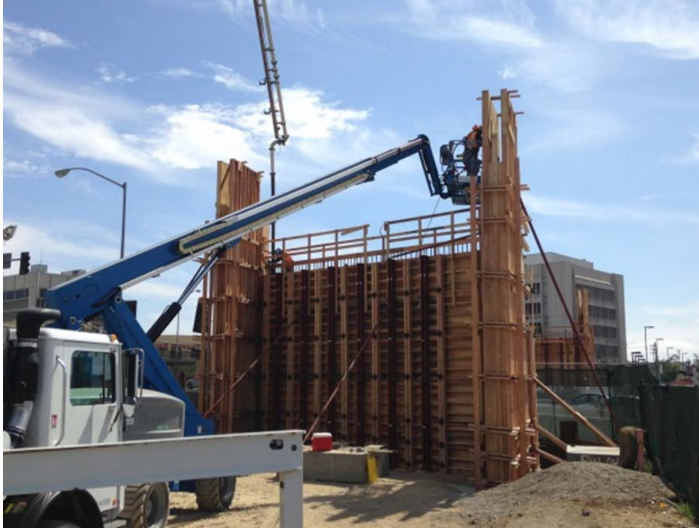
La Brea Abuttment 2 Stem Wall Pour.
