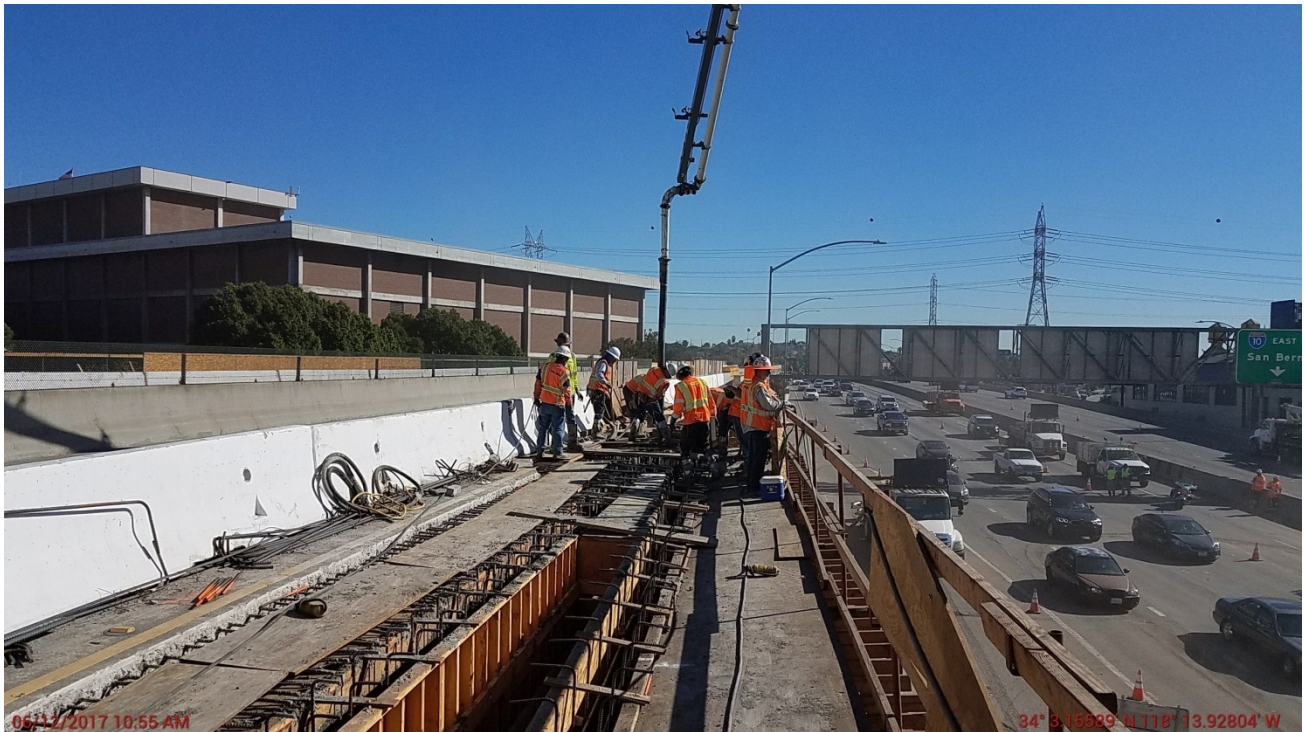
Frame 3 right concrete pour.
