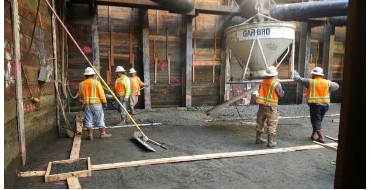
Protection Slab Pour at 2nd/Hope Station
