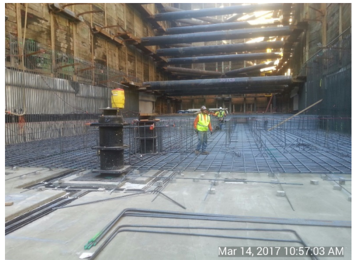
Installation of rebar bottom mat for Pour #2
