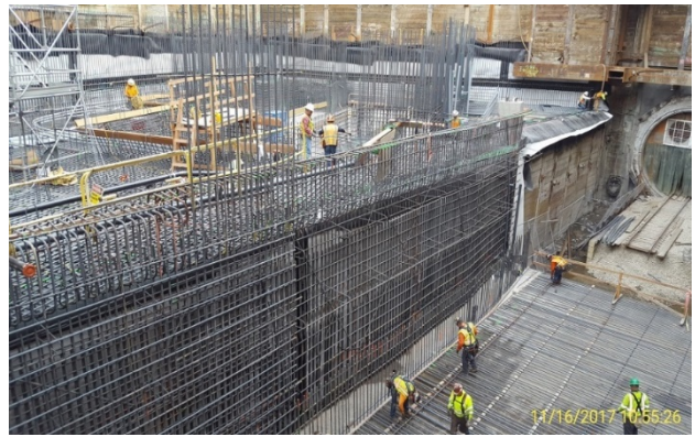
Rebar installation and preparation for wall pour
