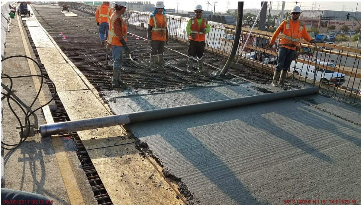
Pour deck for Frame 1 RT.
