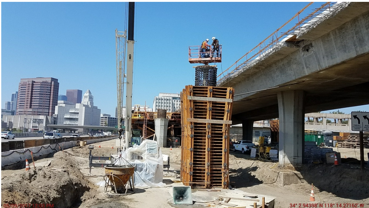
Prep and pour column at Bent 5 RT.
