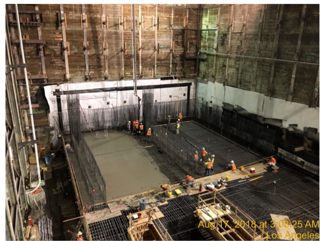
Historic Broadway Station entrance structure pour
