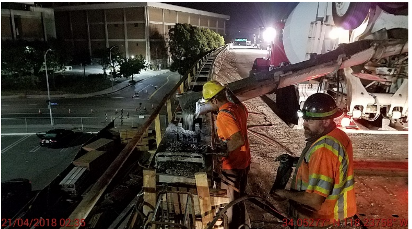
2 nd pour barrier wall on left side.
