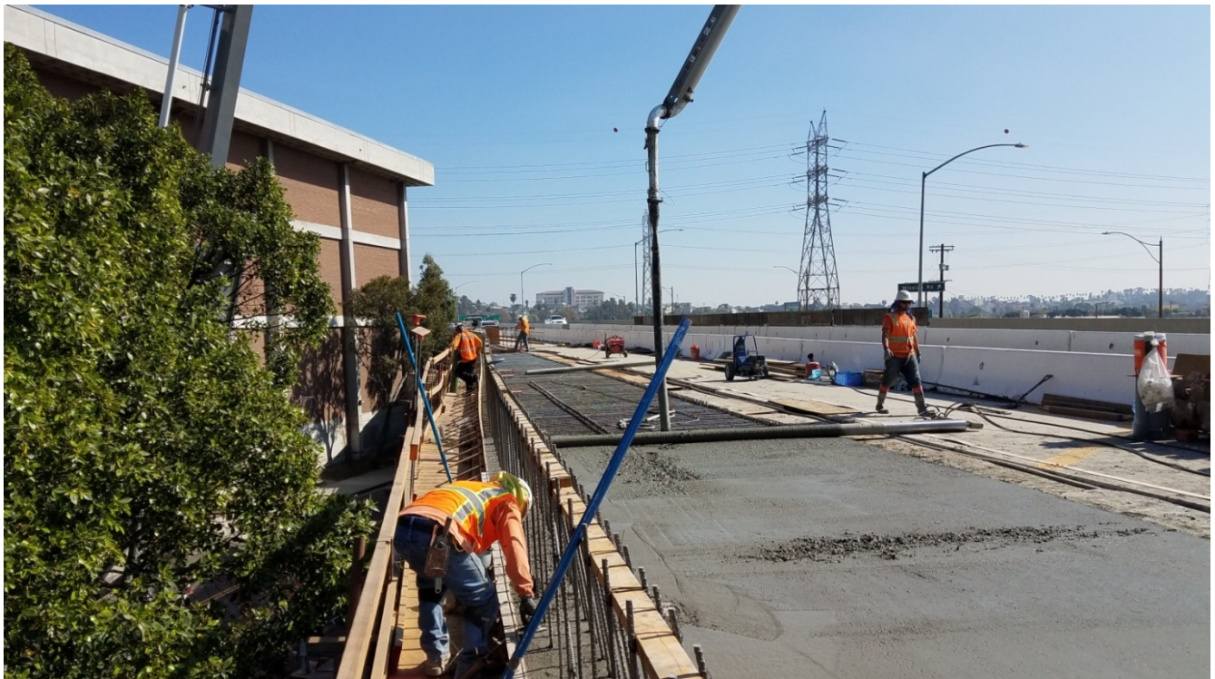
Frame 4 Left Deck Pour.
