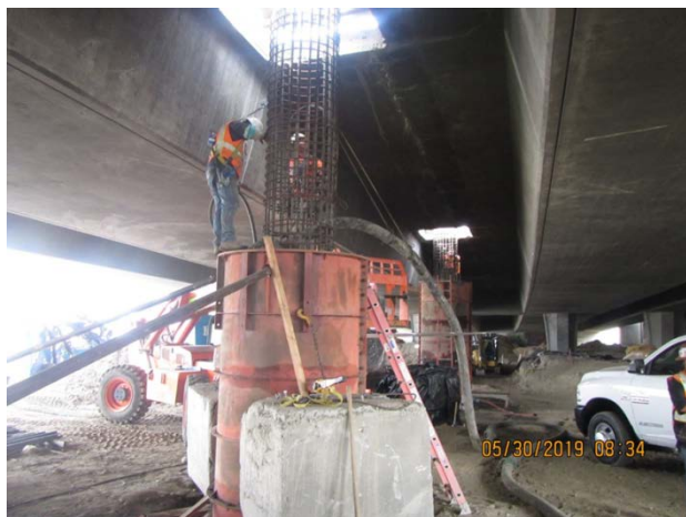
Bent 5 concrete base column pour
