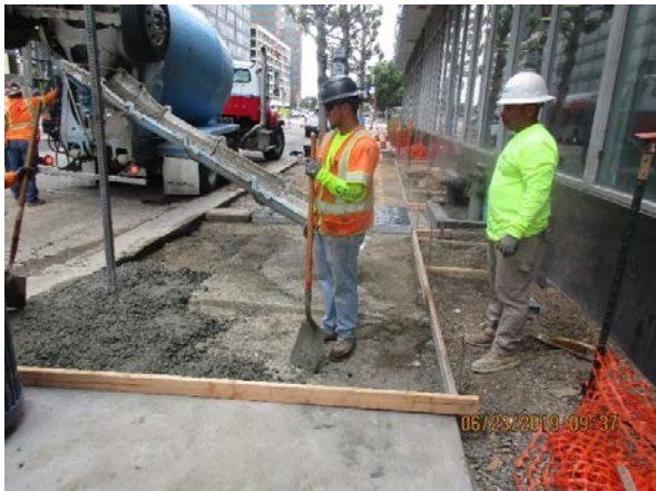
Concrete Pour North Sidewalk 1901 Wilshire Blvd.
