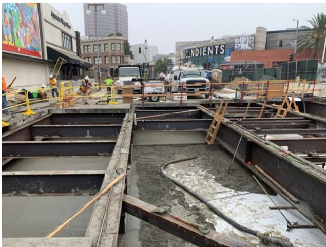
Protection Slab pour for Roof Deck at Central Ave
