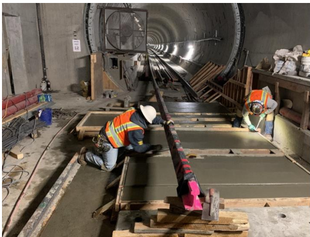
Plinth pour in Crossover Cavern
