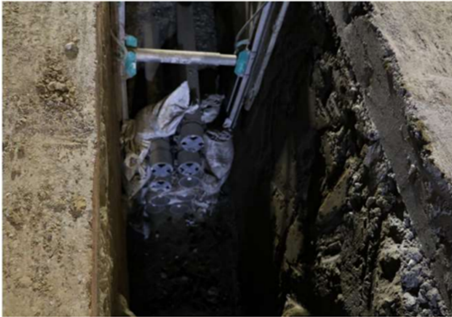
Conduits Installation: Point where new conduits will resume laying
