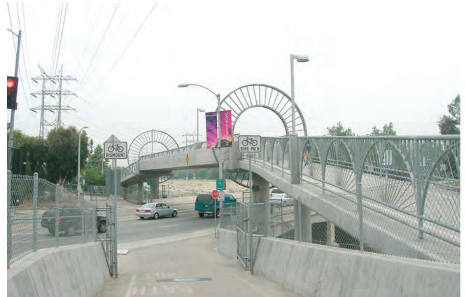
Baum Bike Bridge over Los Feliz Blvd: Los Angeles, CA
