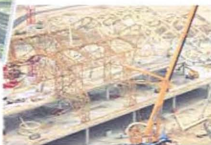
• Edificio Satélite, Nueva Terminal, Aeropuerto Madrid - Barajas.
