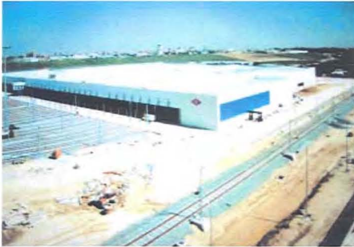
Cuatro Vientos depot and test track.
