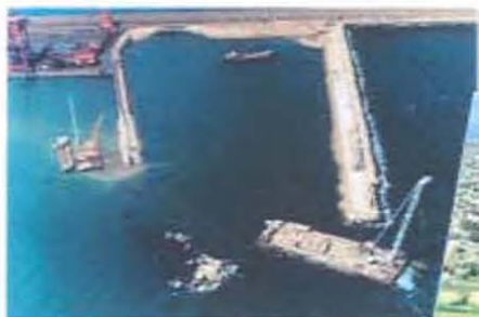
• Muelle de Minerales Puerto de Muel, Gijón, Asturias.
