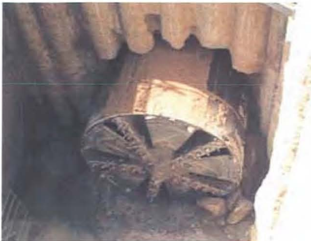
TBM breakthrough at Cuatro Vientos shaft.
