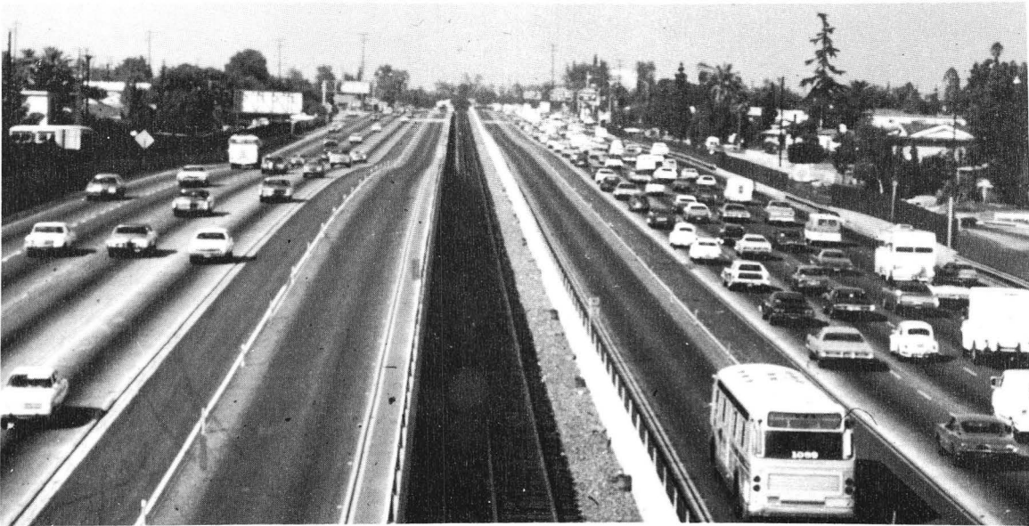
San Bernardino Busway in Los Angeles.
